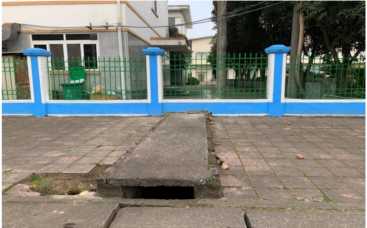
Hình 6. Ảnh vị trí cửa xả nước mưa số 1
