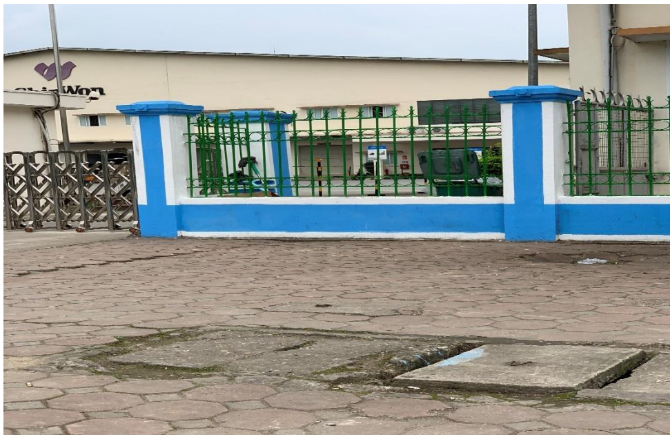
Hình 9. Ảnh vị trí cửa xả nước mưa số 4
