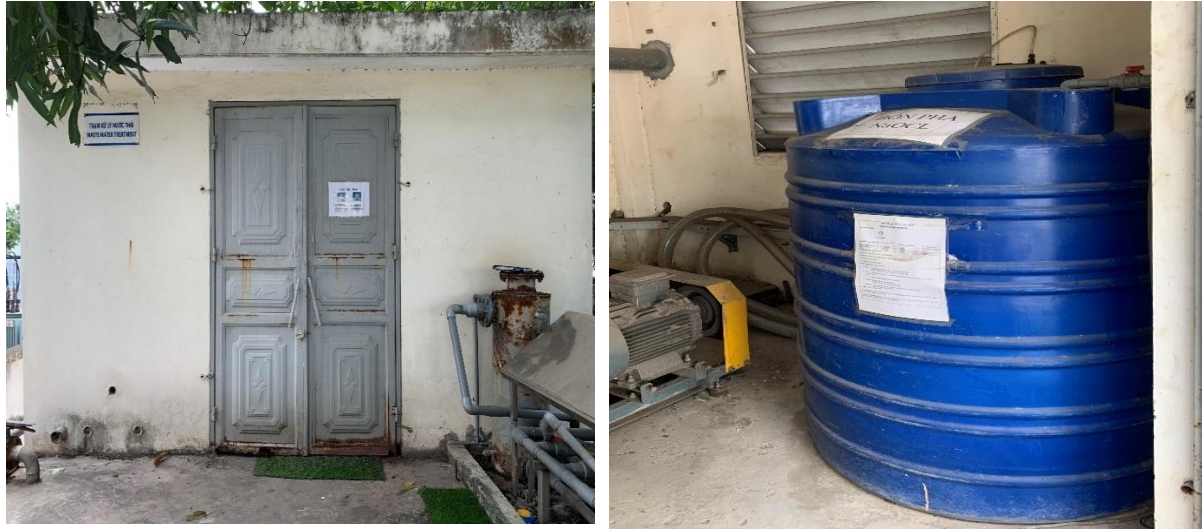
Hình 17. Khu vực nhà trạm lưu chứa hóa chất
